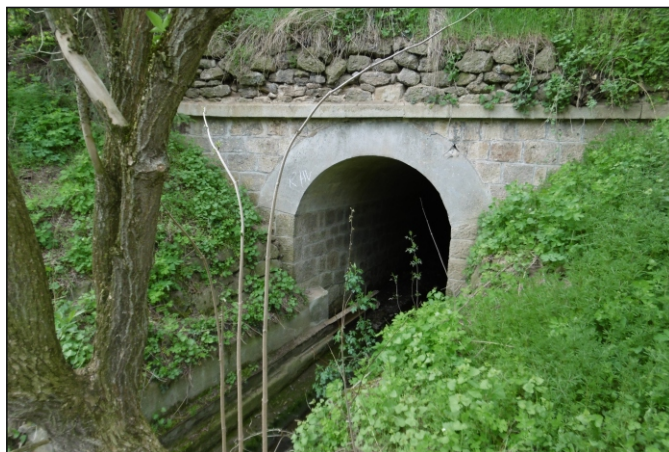
Propustek 9c - staničení 0,229 - pohled zleva
