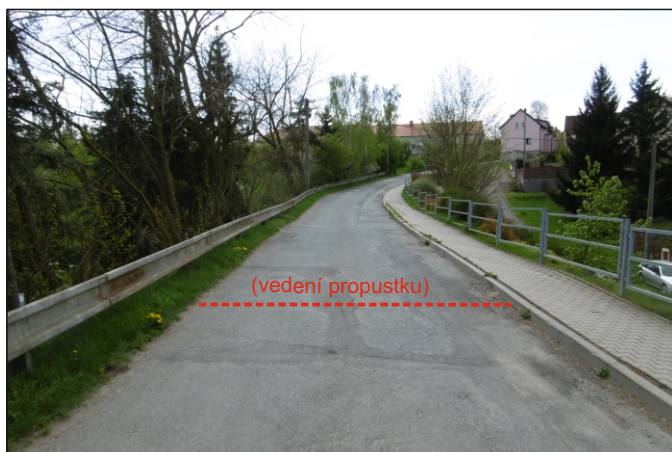
Propustek 9c - staničení 0,229 - celkový pohled
