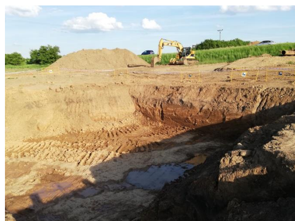
Místo, kde bude stát objekt ČOV...
